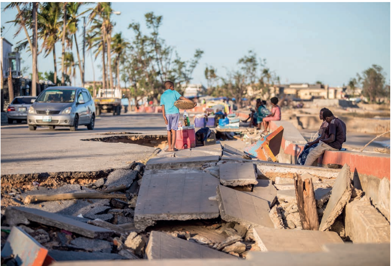
À Beira, au Mozambique, le cyclone Idai a causé d'importants dégâts aux infrastructures de la ville, notamment aux routes. Image : Sarah Farhat/Banque mondiale
